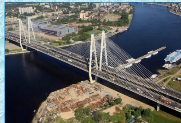
Большой Обуховский (вантовый) мост
